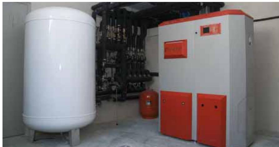
tiene la madera que entra, se aprovechan aproximadamente 3kWh en forma de electricidad. Sin embargo esta misma madera si se utilizase para aprovechar su calor en una caldera de biomasa con un rendimiento del 90%, significaría que de cada 10 kWh que tiene la madera se aprovecharían alrededor de 9 kWh.
